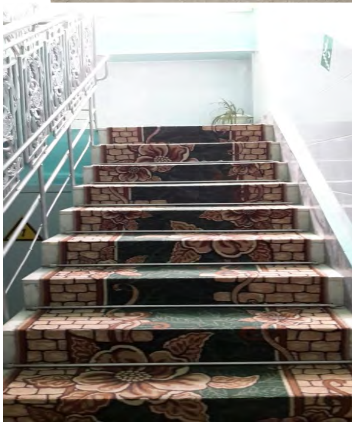
Фото № 2. Лестница внутренняя
